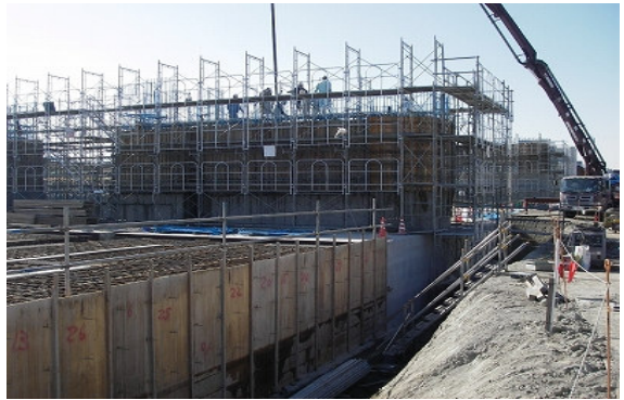
工事現場の作業状況を見学して頂きました
