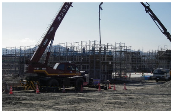
水門本体へコンクリートを打設しているところ
