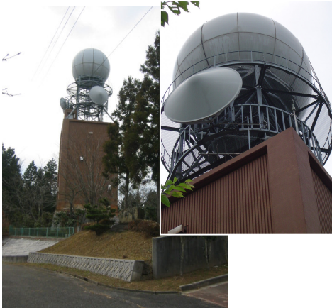
大和山レーダ雨量観測所
