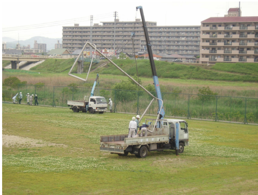
平成23年度撤去訓練の様子（百間川緑地第2工区サッカー場Aにて）
