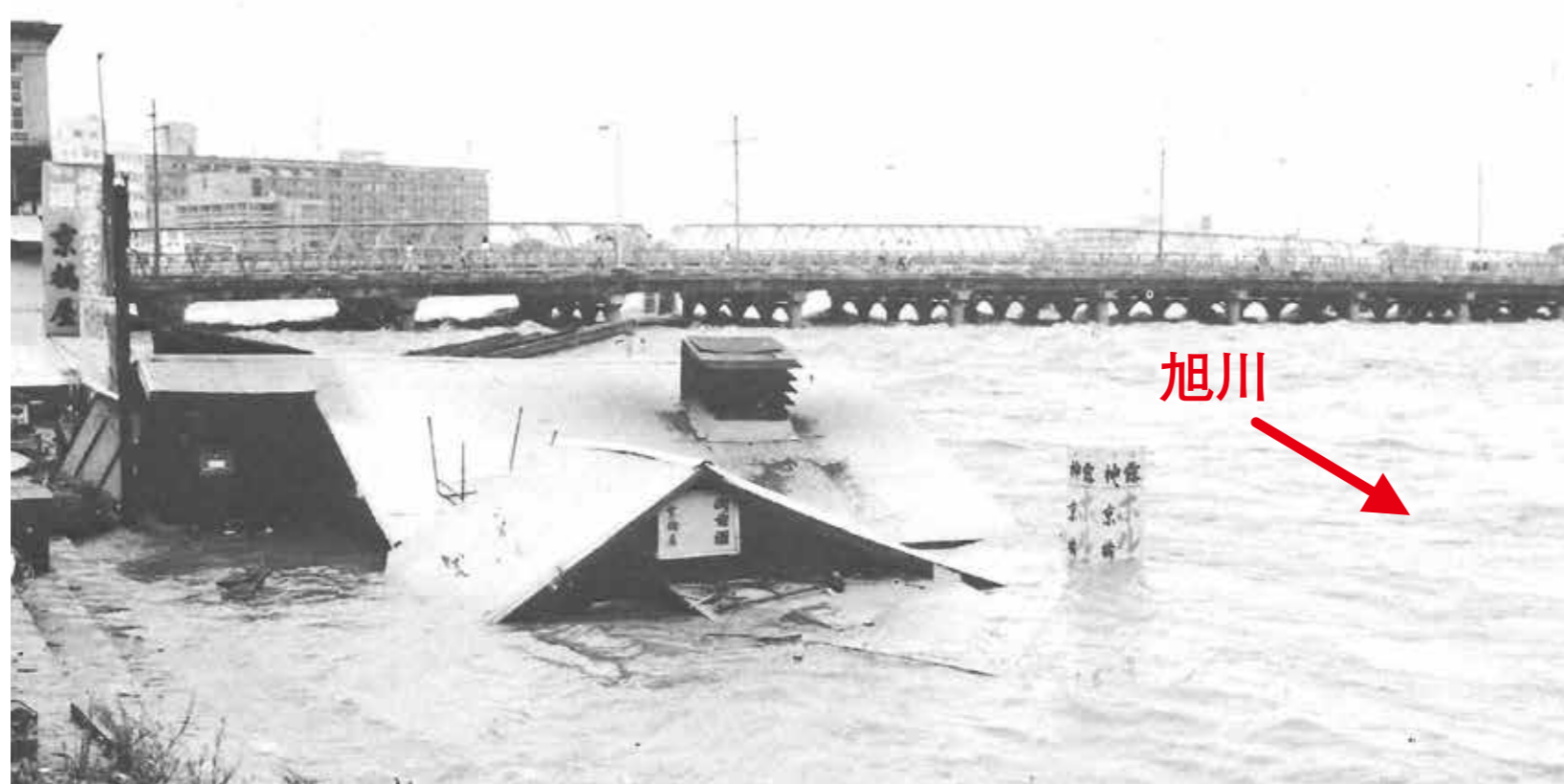
昭和47年7月洪水(岡山市北区 京橋地区)
