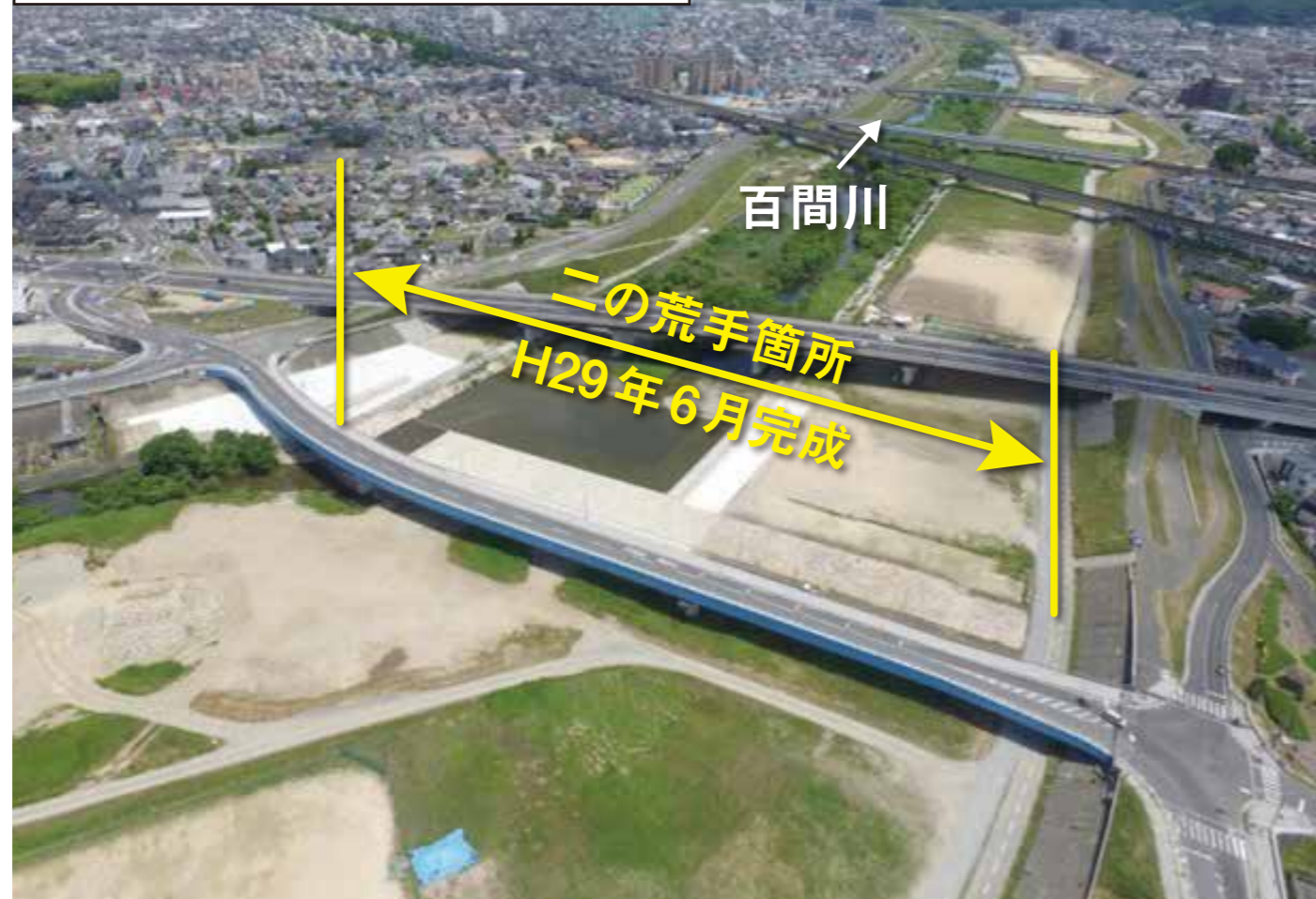
二の荒手現状 (平成29年6月)
