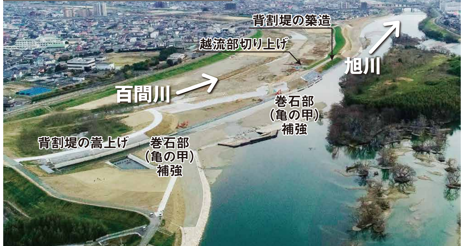
百間川分流部「一の荒手」周辺の整備後
