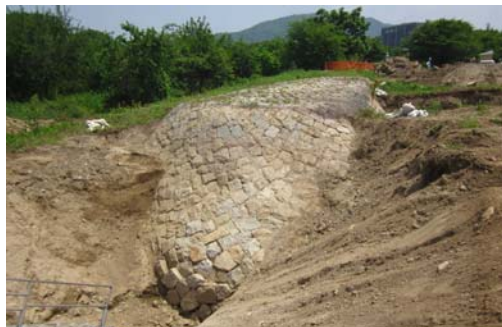
下流巻石部(亀の甲)の現状 上流巻石部(亀の甲)の現状
