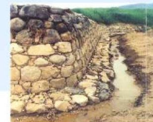
二の荒手左岸 導流堤の根固捨石
