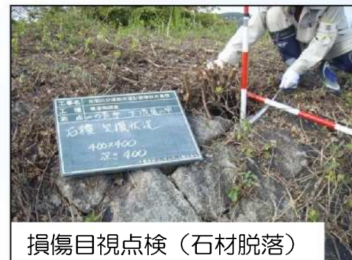
寸法計測（根入れ調査）
