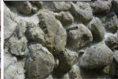
写真2-施工後の石積
