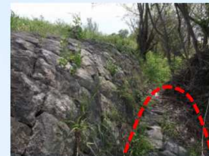
下流亀の甲（旭川側）の石積み
