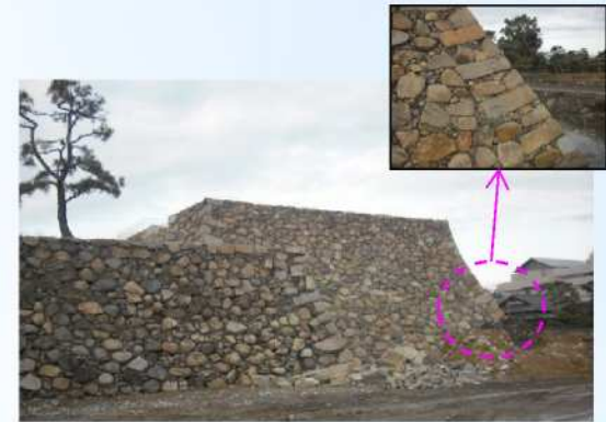
例2：修復後写真
