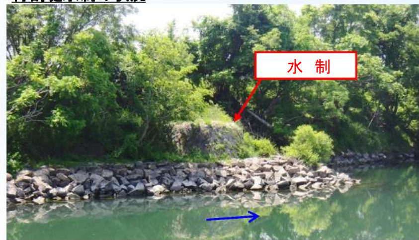
一の荒手下流の水制工
