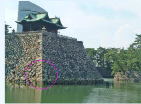
例1：解体前写真
