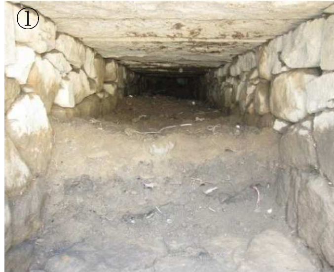
① 暗渠内部の状況
