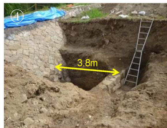
④ 亀の甲前面に石積みが存在
