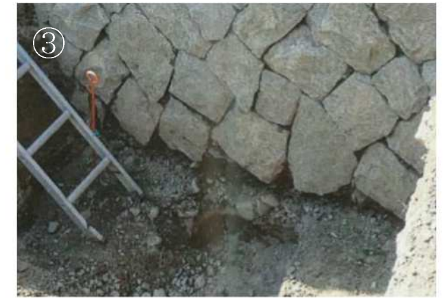
基盤部の状況
