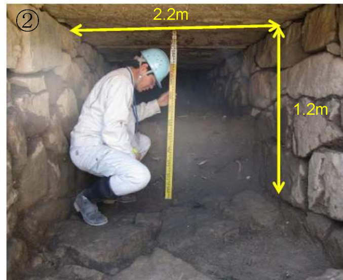
② 暗渠内部の状況(B2.2m×H1.2m) 底部も石張り構造
