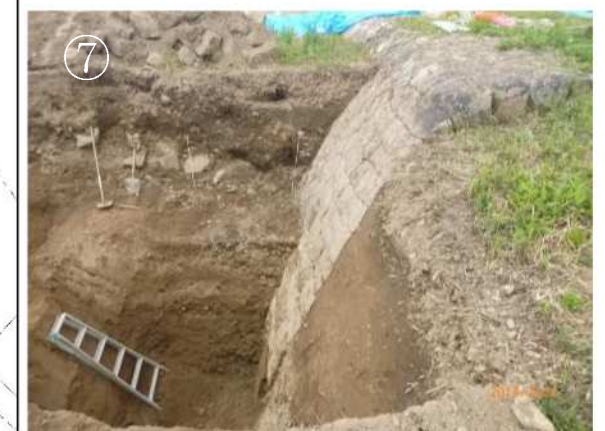
⑦ 上流側端部
