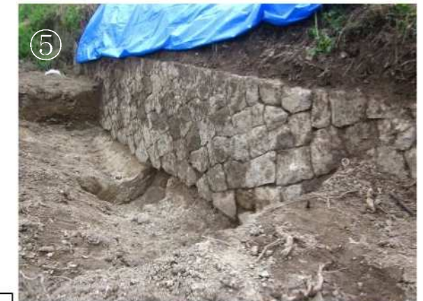
⑤ 旭川側の試掘状況 (旭川の石積護岸があり、亀の甲前面の掘削はしていない)
