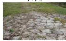
一の荒手巻石部(亀の甲)(上流)
