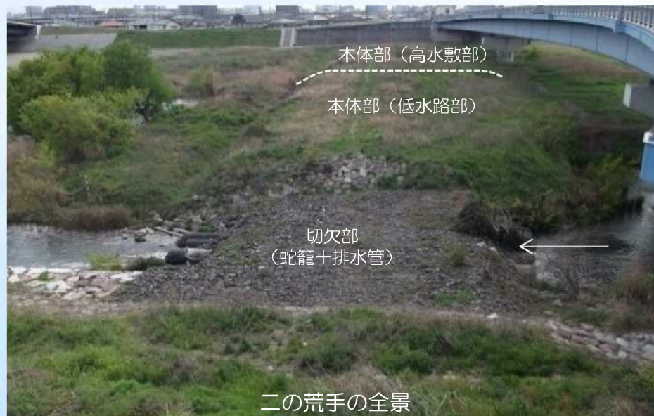
左岸導流堤復旧の様子
