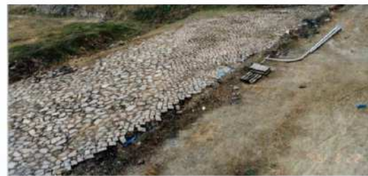
左岸導流堤復旧の様子
