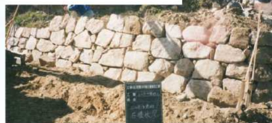
左岸導流堤復旧の様子
