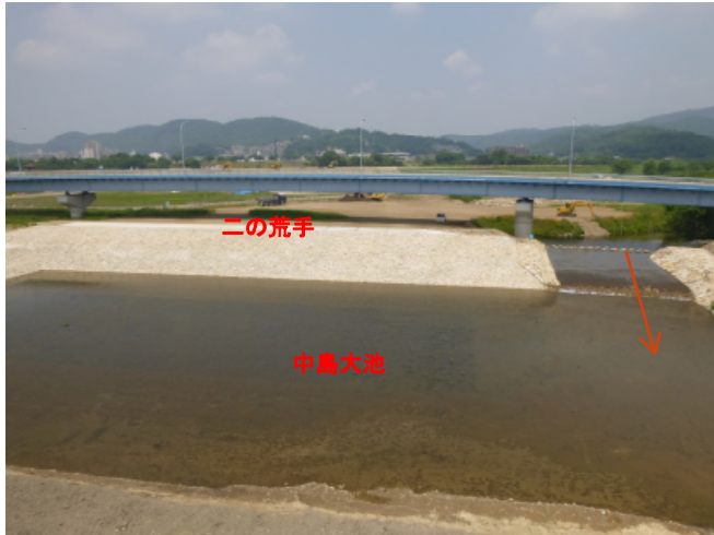
二の荒手完成状況（H29.6）
