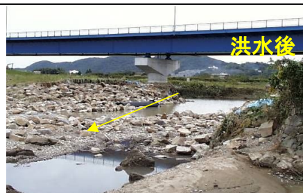
二の荒手被災状況 (平成10年10月洪水)
