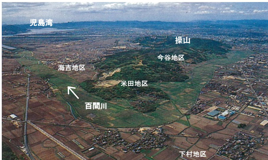
改修前の大曲付近
