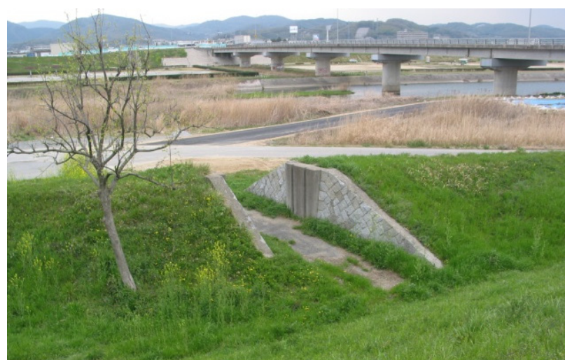
陸閘跡と橋梁(米田橋)
