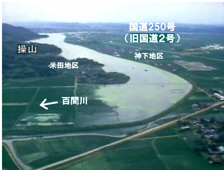
築造当時の姿を残す改修前の様子：洪水時（昭和40年）
