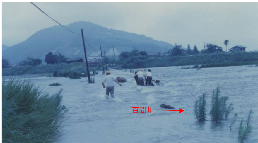
改修前の洪水時の様子:(昭和40年、岡山市中区海吉地区)
