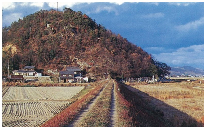
貧弱な堤防(海吉地区)
