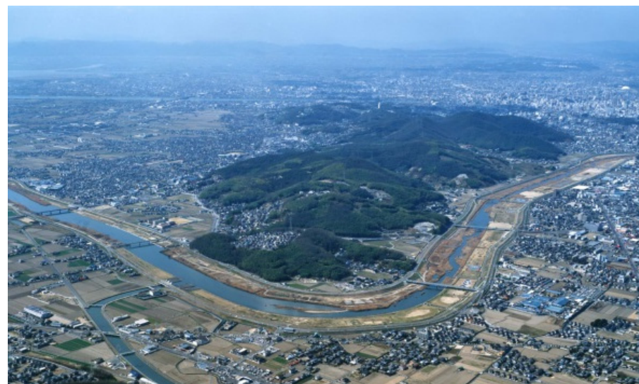
改修後の大曲付近
