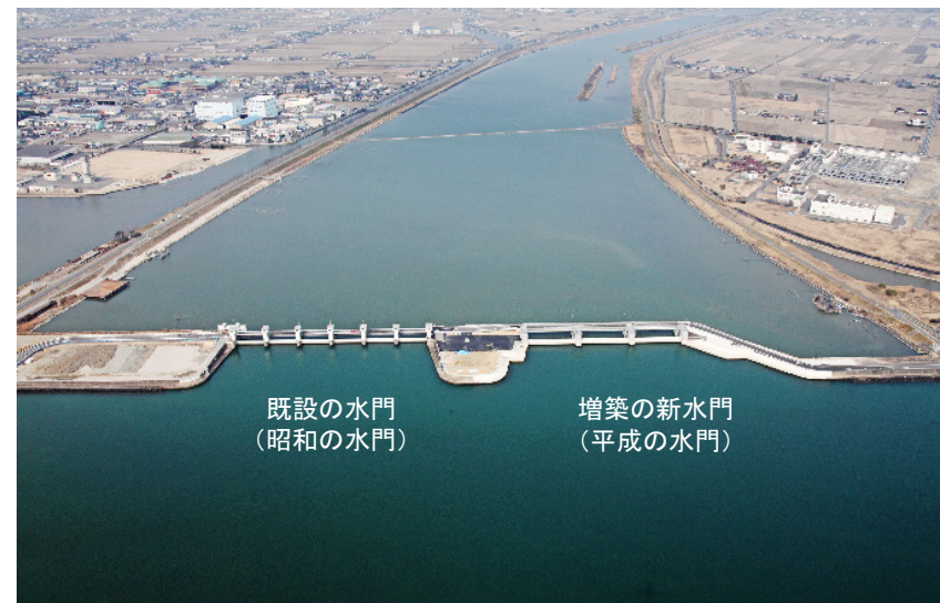
河口水門周辺の様子(平成27年撮影)
