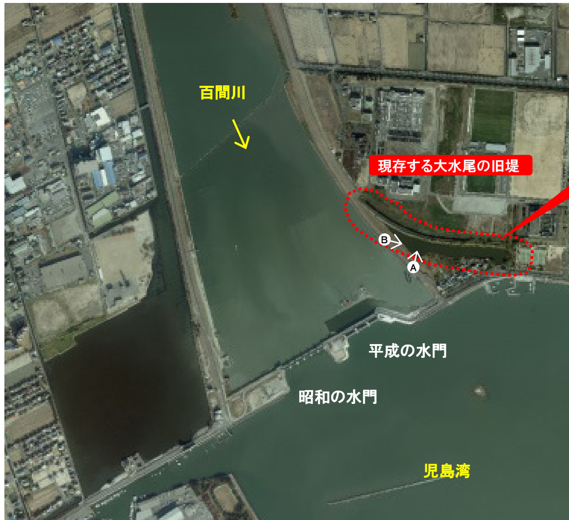
河口水門周辺の様子(平成27年撮影)
