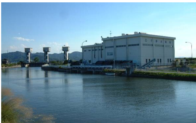
乙子排水機場（千町川）
