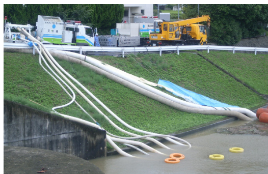
排水ポンプ車出動状況 (平成23年9月台風12号)
