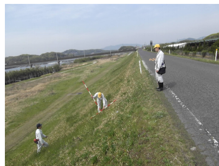
堤防点検の実施状況
