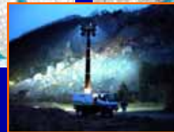
平成13年3月12日美袋崖前 照明車設置状況
