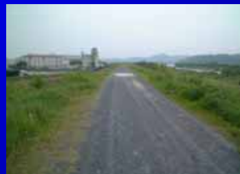
高梁川の堤防天端
