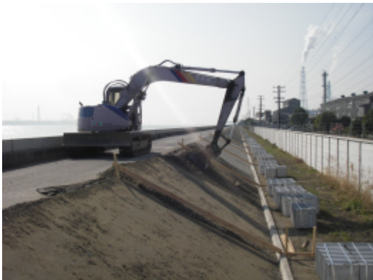
H18 高潮対策事業 ( 施工状況 ) (H19.1.30)
