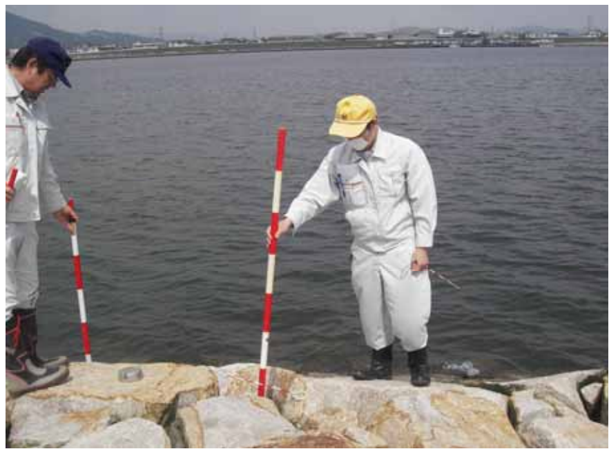
実施状況 水制の捨石の変状を点検
