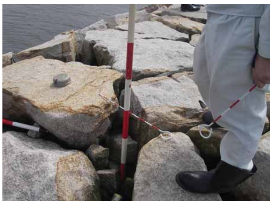
実施状況 水制の捨石の変状を点検
