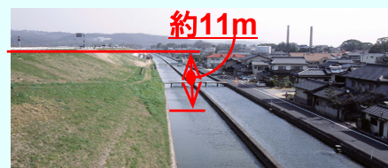
酒津地区の堤防の状況
