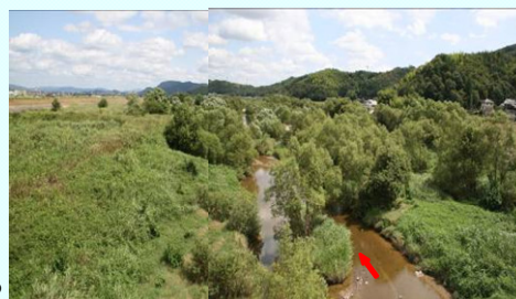
樹林化の現状(小田川矢形橋付近)
