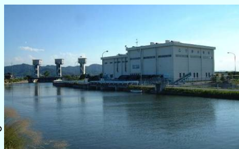
乙子排水機場(千町川)
