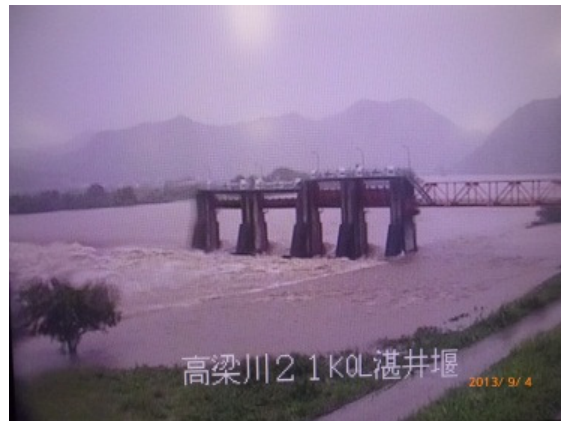
高梁川21k左岸 湛井堰
