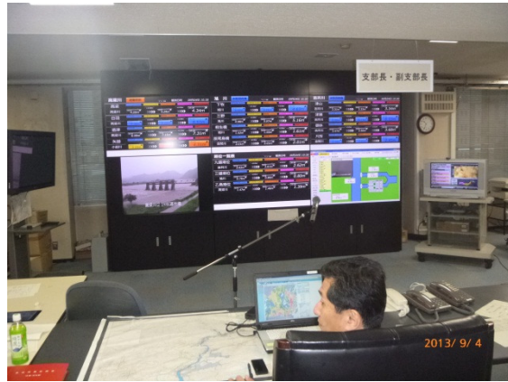
水位データ表示モニター
