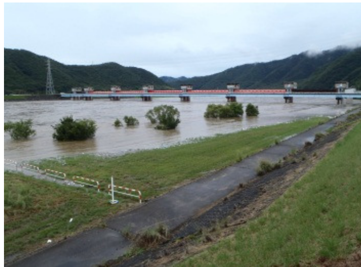
坂根堰全開状況
