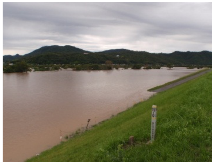
河川敷冠水(総社市井尻野)
