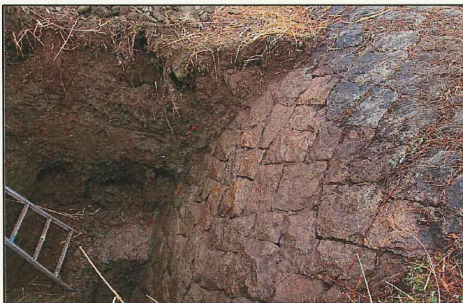
上流亀の甲石積み状況
