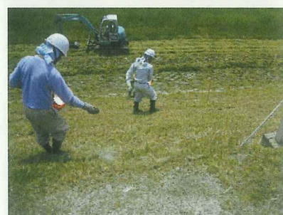
旭川での試験施工の様子(H24年度)
