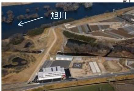
今在家河川防災ステーション
