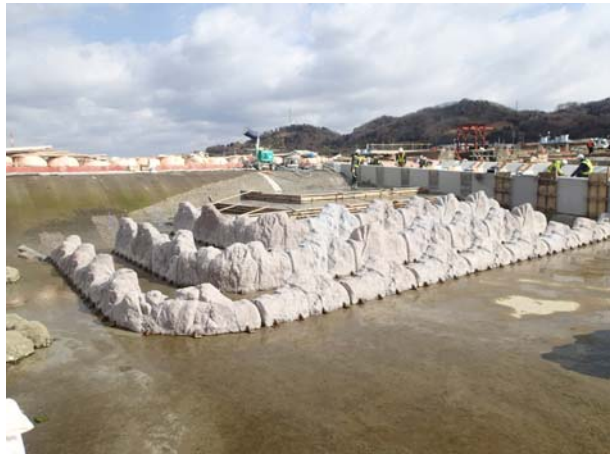
柵田式簡易魚道（新設）
