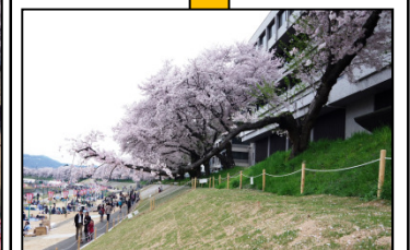
昨年度の護岸工事の実施状況
