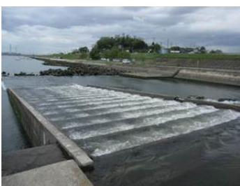
改良後の4号魚道
