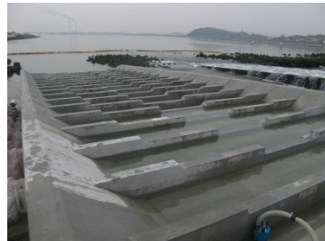
改良後の1号魚道
