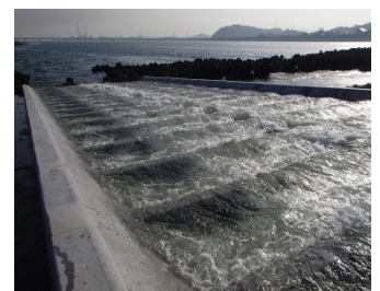
改良後の2号魚道
