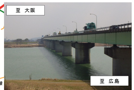
【写真①】高梁川大橋施工予定箇所
