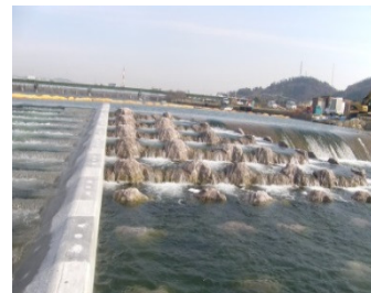
改良後の1号魚道(簡易魚道部)
