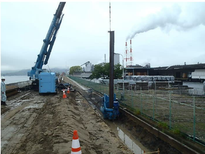
【参考】高潮耐震工事状況（鋼矢板圧入）
