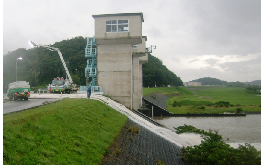
排水ポンプ車による排水の様子
