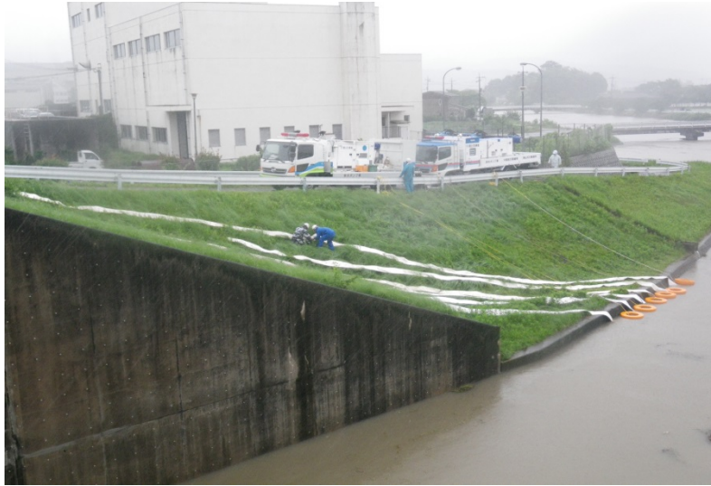
排水ポンプ車設置の様子
