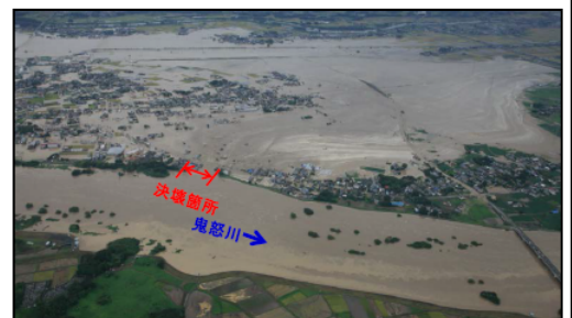
平成27年9月鬼怒川の氾濫による 茨城県常総市の被災状況
