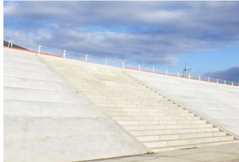
改修後の階段
