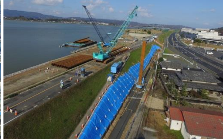
堤防工事と耐震・液状化対策の状況
