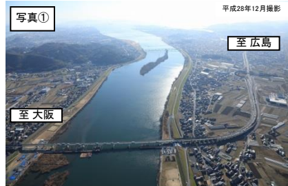
【写真①】上流側より望む
