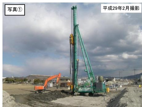
【写真①】藤田地区の施工状況(地盤改良)
