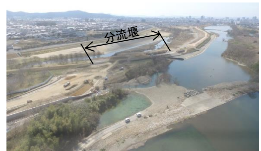
現地状況(H29.3撮影)
