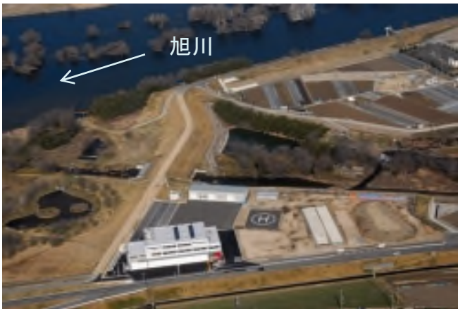
防災ステーション全景
