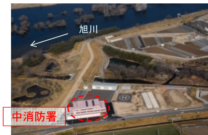
防災ステーション全景
