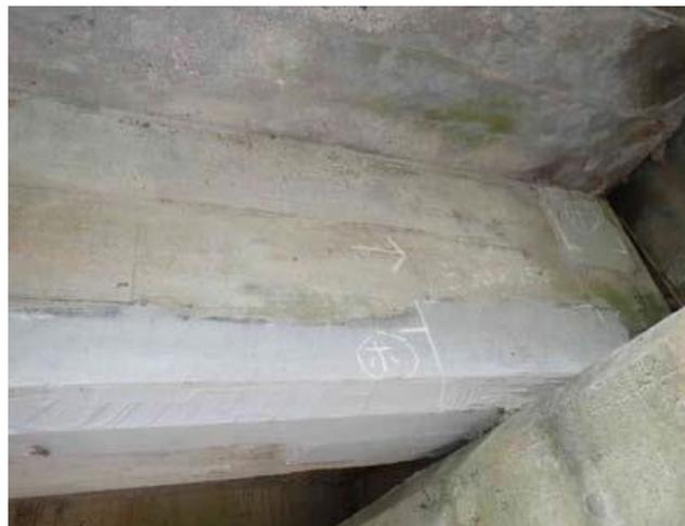
主桁の断面補修
