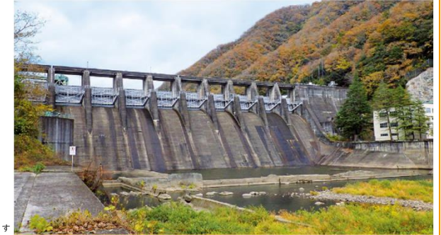
既設旭川ダム
