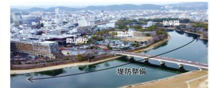
堤防整備(中国地方整備局)
