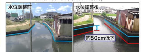
既存農業用水路を活用した事前水位調節(岡山市)
