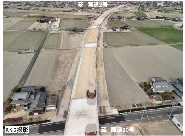
【写真①】 藤田地区 施工状況
