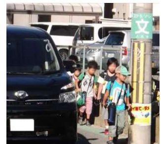
<歩行の支障となる電柱の事例>
