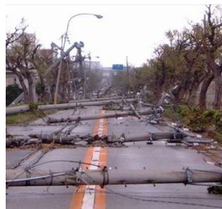
<電柱の倒壊による道路閉塞の事例>
