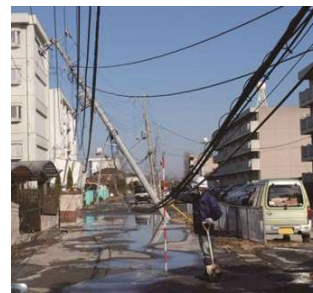
<電柱の倒壊による道路閉塞の事例>
