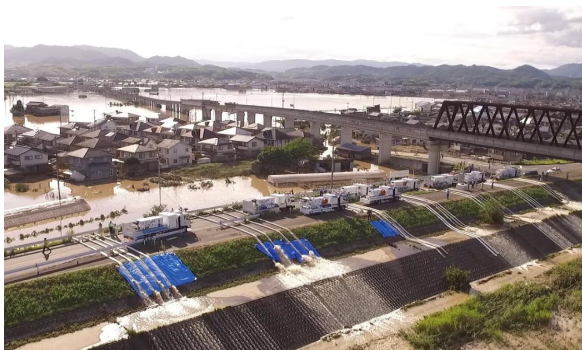
排水ポンプ車の排水状況 (倉敷市真備町地先 平成30年7月)
