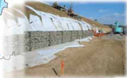
堤防質的整備
