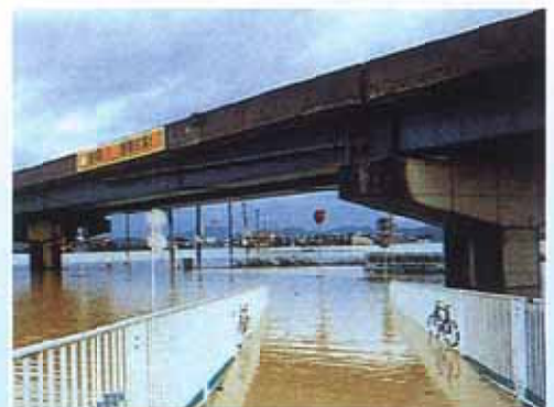
ブルーライン高架下日瀬西大寺線
