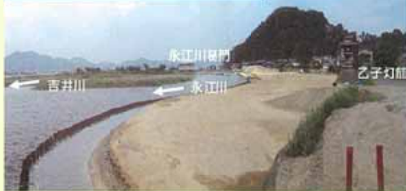
整備状況(整備区間下流部から)
