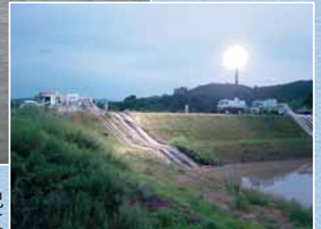
排水ポンプ車稼働状況 岡山市中原地区
