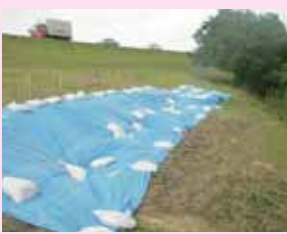
総社市古地地区の被災状況
