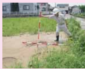
総社市清音地区の漏水状況
