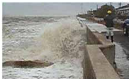
台風16号による高潮被害
