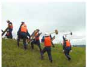
杭打ち(鋼製マット工)
