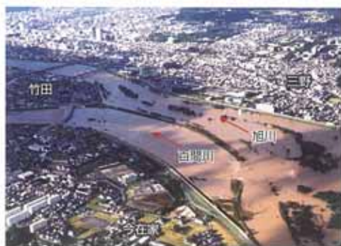
平成10年一の荒手越流状況
