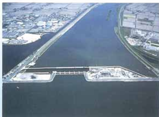
増設工事中の百間川河口水門
