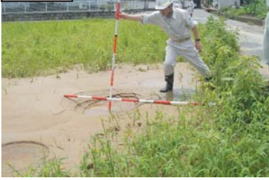
基盤漏水による被災状況 (川から離れた田から土と水が噴出)
