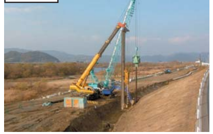
対策実施状況 (地中に止水壁(鋼矢板)を設置)
