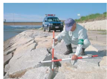
河川巡視状況
