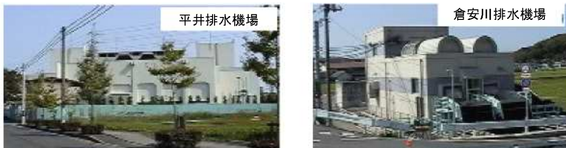
図 3.2.1 平井、倉安川排水機場の現状(左：平井排水機場、右：倉安川排水機場)
