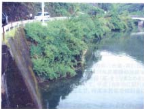
調査地風景(旭川ダム)
