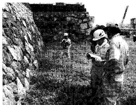
旭川堤防を点検する 岡山河川事務所職員
