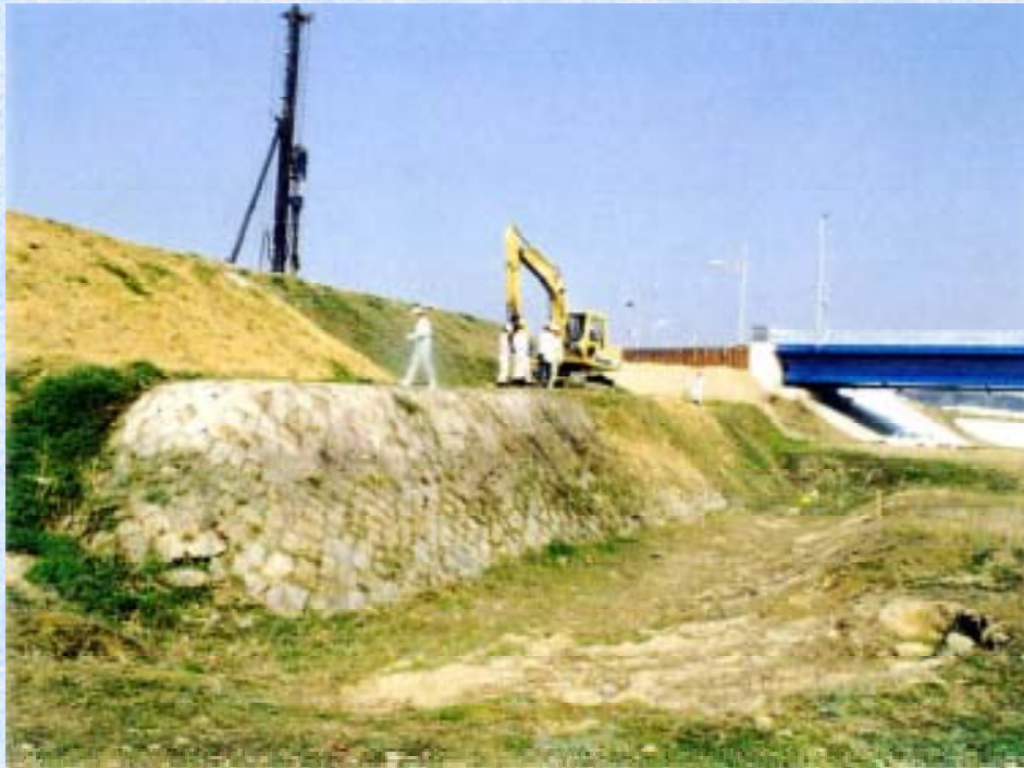
二の荒手右岸導流堤、調査前
