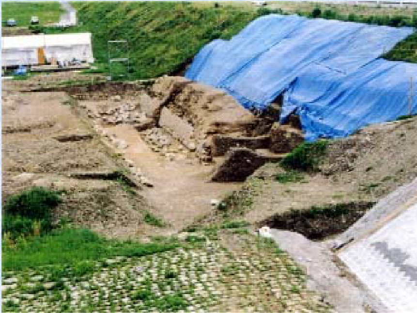
二の荒手右岸導流堤旧石積み状況
