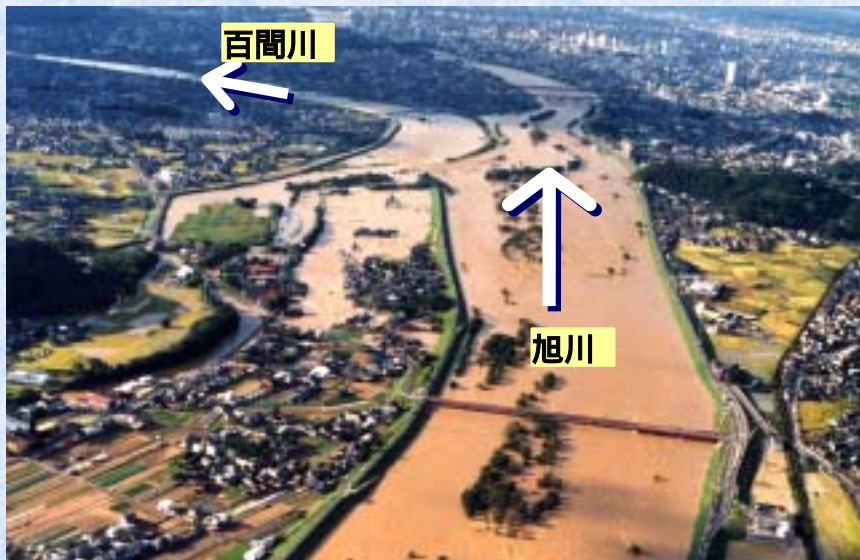
平成10年洪水の状況（一の荒手）
