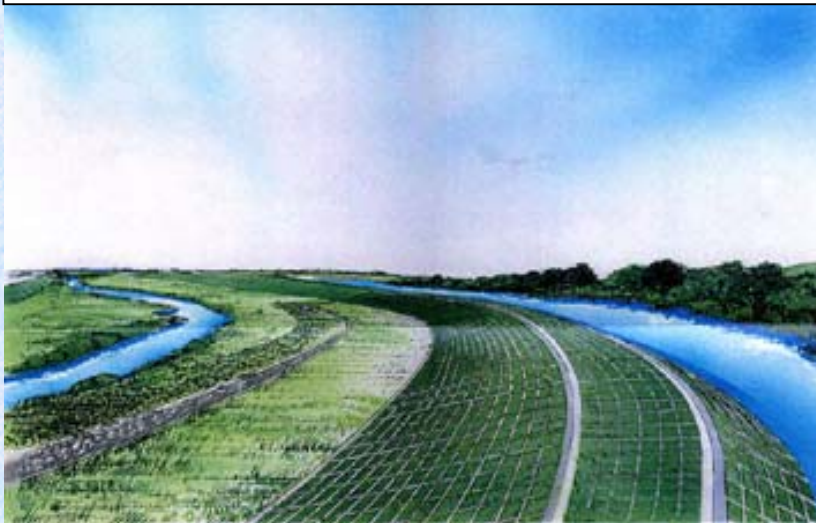
一の荒手の詳細構造(ポーラスコンクリート案)
