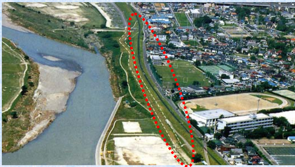
緊急河川敷道路
